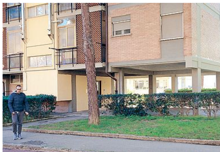
ZONA RESIDENZIALE Uno dei condomini di via Meda presi di mira dai vandalismi: i residenti sono sul piede di guerra
